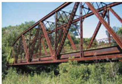
Ponte em processo de corrosão, antes de ser totalmente renovada
