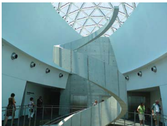
O elemento de vidro é formado com tubos de aço estrutural criando uma possibilidade inovadora reconhecida como novo paradigma em geometria de estrutura de vidro no mundo arquitetônico
